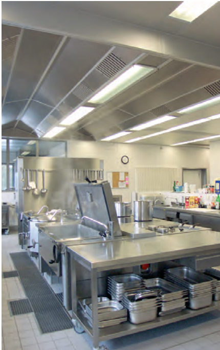
Abb. 6: Küchenlüftungsdecke
