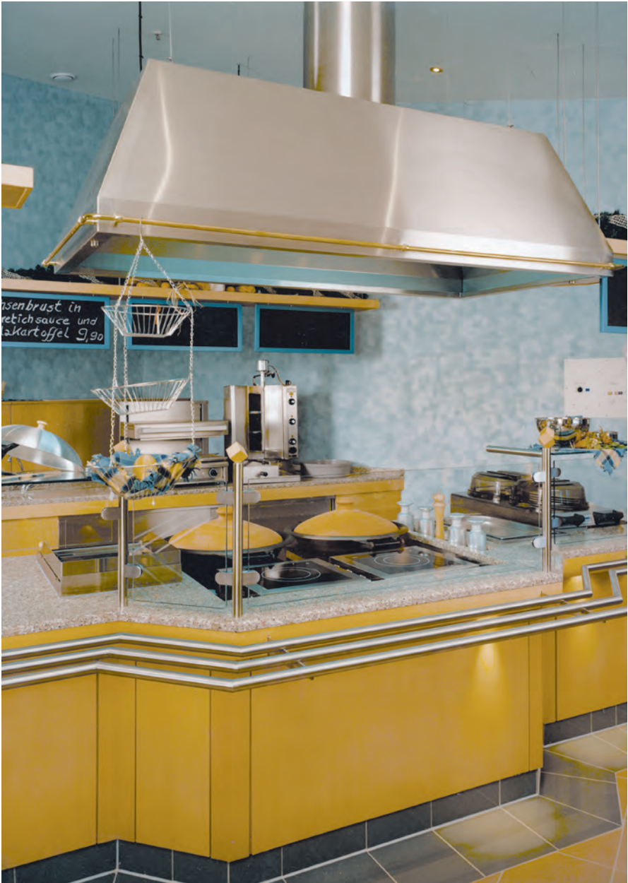
Abb. 8: Küchenlüftungshaube „front cooking“
