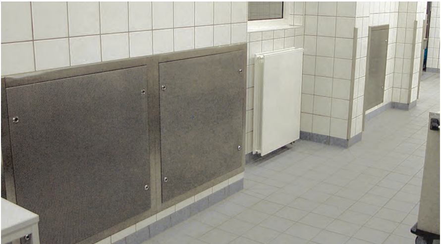
Abb. 16: Flächenförmiger Quellluftdurchlass vor der Wand positioniert (mit Spritz- bzw. Reinigungsrand)
