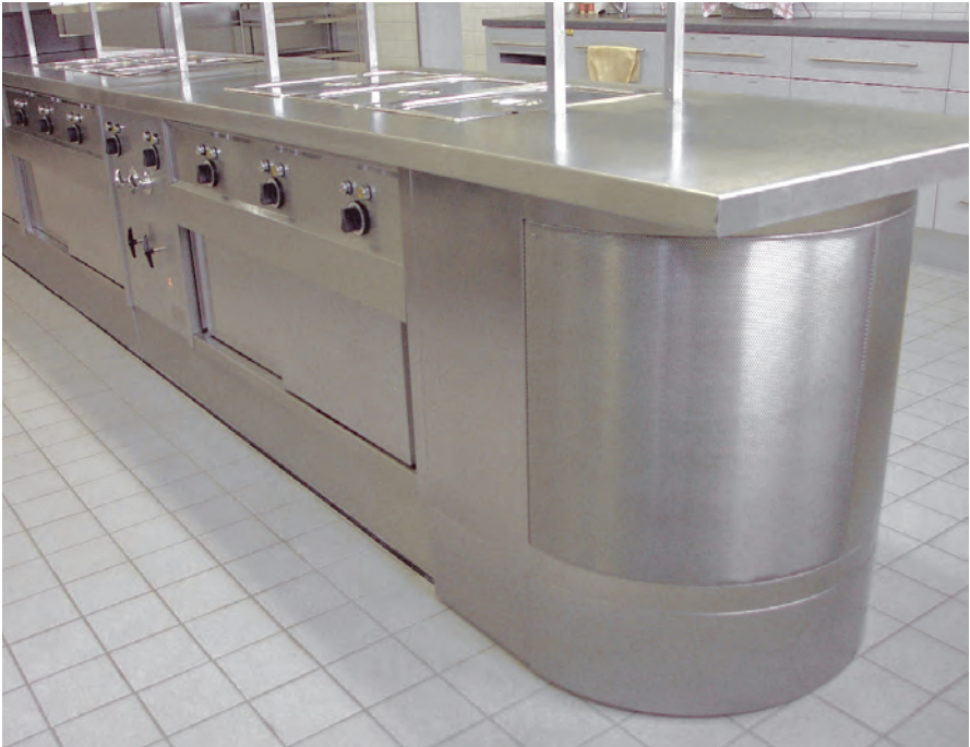
Abb. 17: Quellluftdurchlass in Küchenmöbel integriert (Abstände zu Arbeitsplätzen wegen Zuggefahr prüfen. Außen und innen reinigbar.)
