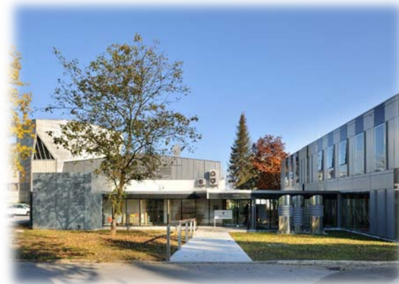
V letu 2015 odprtih 1100 m 2 novih in 800 m 2 prenovljenih površin, vključno z laboratoriji
