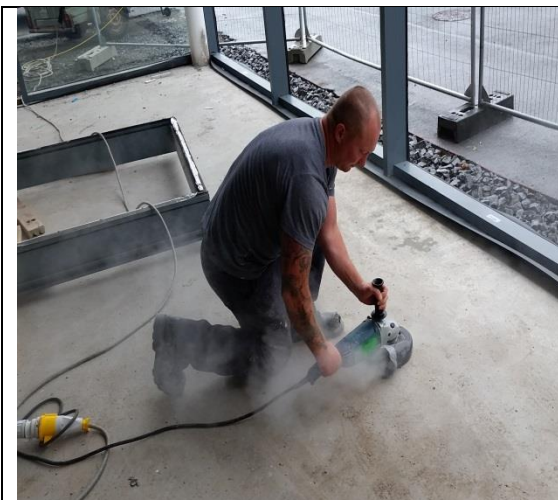
Slaba praksa – uporaba ročnega orodja za dletenje brez odsesavanja pri orodju (HSA, IE)
