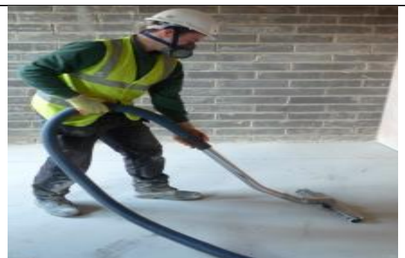
Dobra praksa – odstranjevanje prahu s sesalnikom z visokoučinkovitim zračnim filtrom za delce (HSE, GB)
