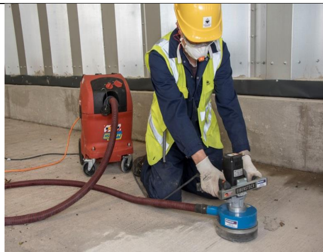
Dobra praksa – uporaba ročnega brusilnika z odsesavanjem pri orodju (HSE, GB)
