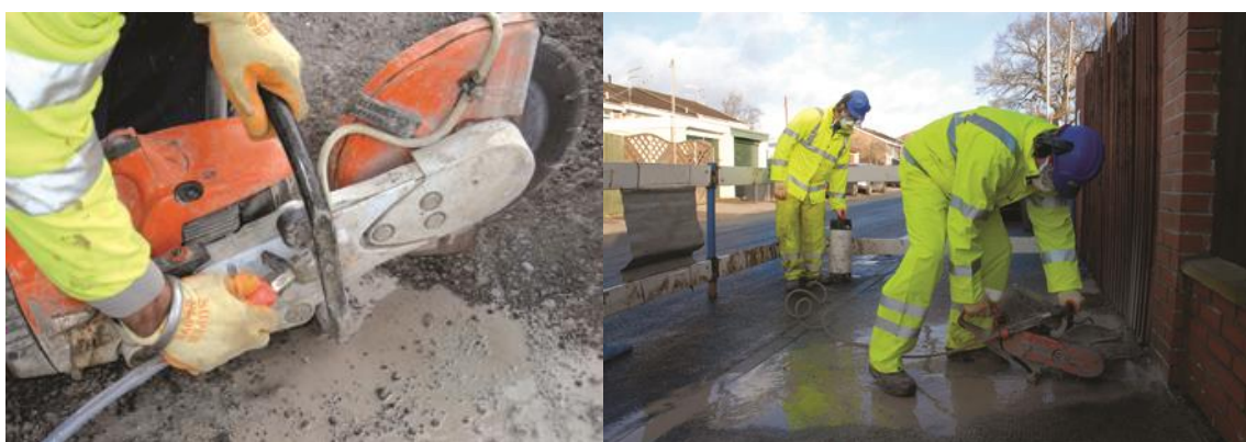
Slika 2: fotografije, ki prikazujejo sistem za preprečevanje prašenja s pomočjo vode (vir: HSE, GB)
