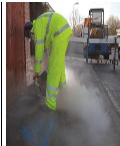
Slaba praksa – brez preprečevanja prašenja ali uporabe varovalne opreme za dihala (HSE, GB)
