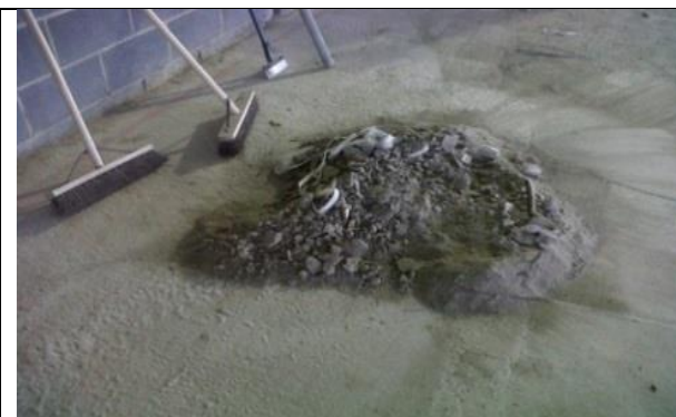
Slaba praksa – odstranjevanje grušča s suhim pometanjem (HSE, GB)
