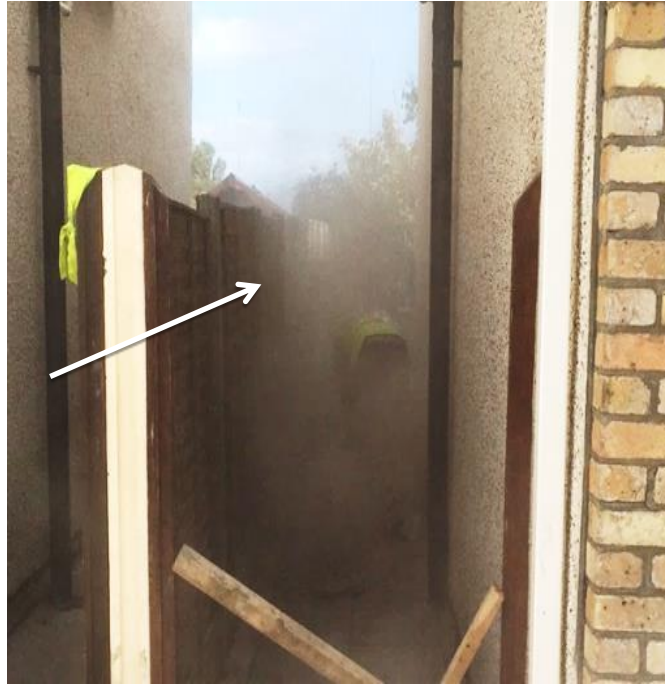
Slika 1: Delavec, ki mu grozi visoka raven izpostavljenosti vdihljivemu kristaliničnemu silicijevemu dioksidu. Puščica kaže na delavca (vir: HSA, IE).
