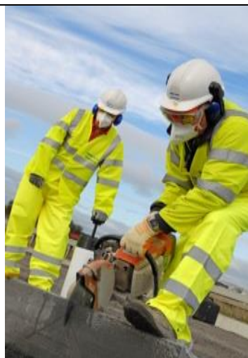
Dobra praksa – preprečevanje prašenja s pomočjo vode in uporaba varovalne opreme za dihala (HSE, GB)
