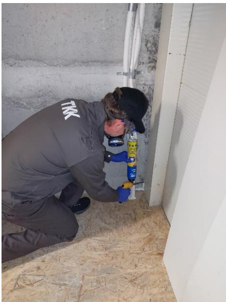
Slika 6: Ustrezna uporaba osebne varovalne opreme pri uporabi enokomponentnega poliuretanskega lepila
