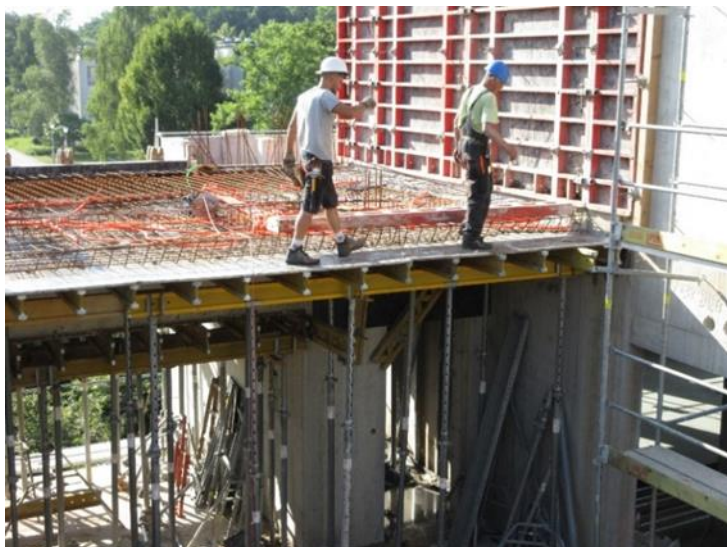
Slika 9: Nevarno izvajanje dela na višini
